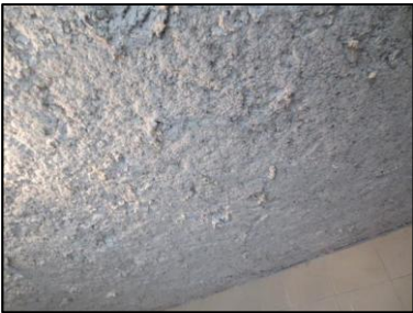
Photo N° 898 ECH-N°1 FLOCAGE - -LOCAL VO RDC Plafonds Flocage
